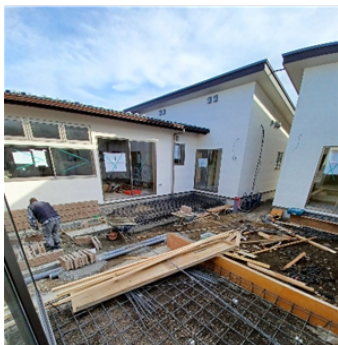
※ 工事中の中庭です。
