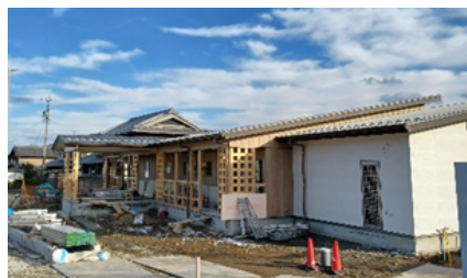
※ 入り口と車寄せ 工事中です
