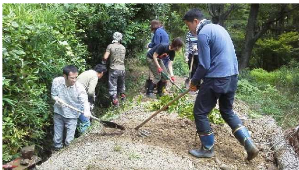
土砂崩れに備え側溝を掃除しました
